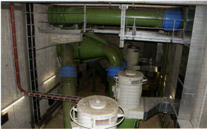
Hier im Pumpenraum des Schiffshebewerkes müssten Turbinen eingebaut werden, damit aus der durch Wasserflüsse frei werdenden Energie Strom werden kann.
